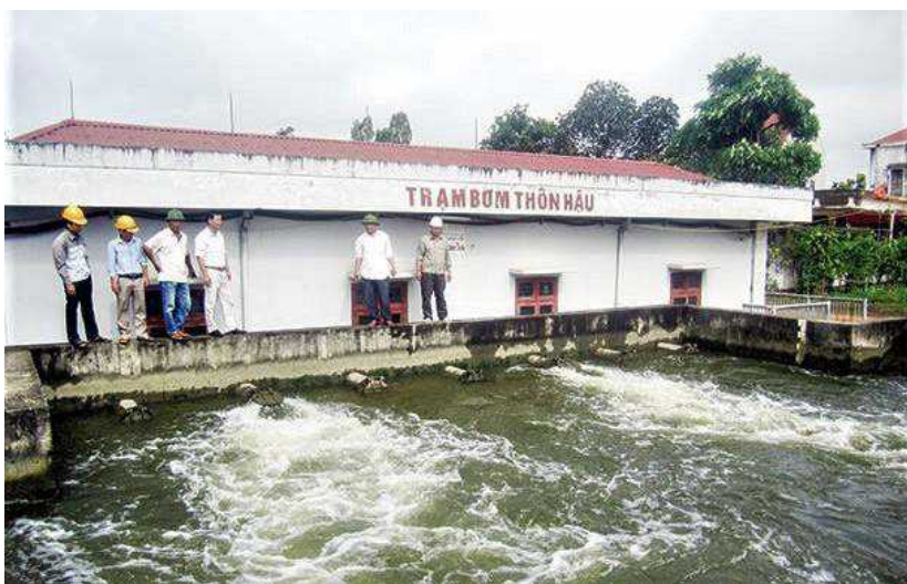
Trạm bơm thôn Hậu (xã Phú Lộc, huyện Hậu Lộc) vận hành bơm tưới nước phục vụ sản xuất nông nghiệp.
